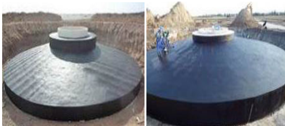
Примери темељења стубова ветрогенератора
