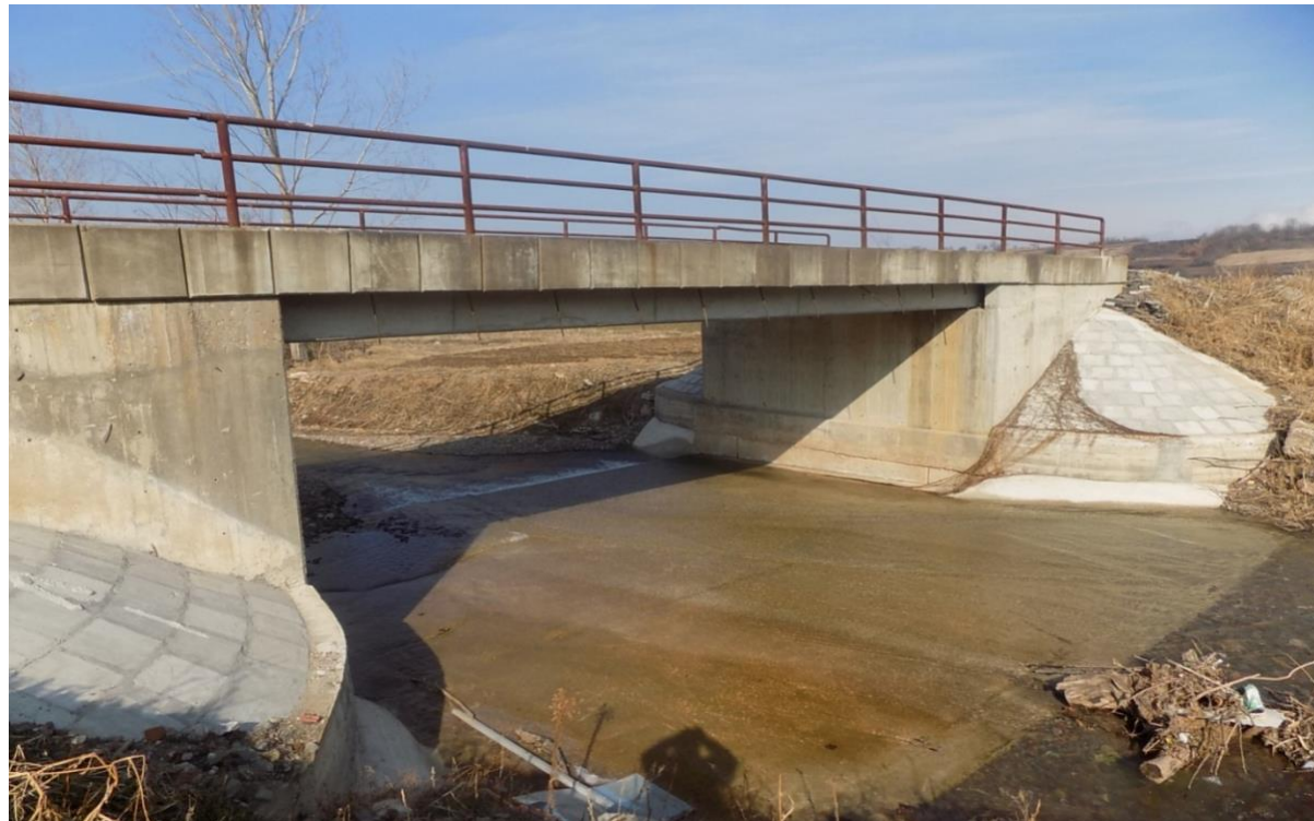
Реконструкција моста над Великом реком. Вредност радова 1.800.000,00 динара.
